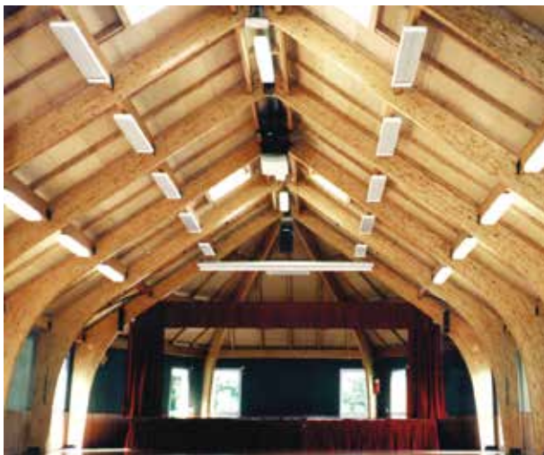
Инфракрасный обогрев - идеальное решение для нерегулярно используемых помещений. Времени на предварительный прогрев требуется значительно меньше.
