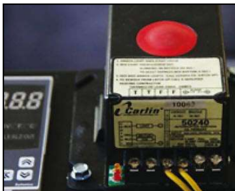
Контролер горелки
