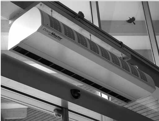
Рис. 3 – монтаж над входными дверями
