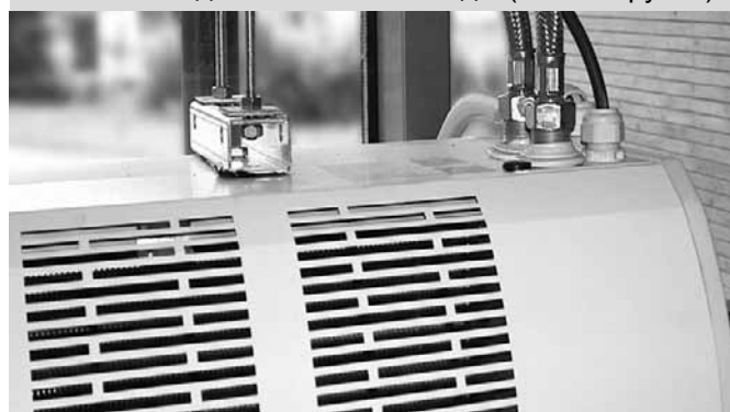
Рис. 13 – подключение отоп. воды (гибкие трубки)
